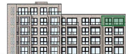
Lage im Haus (Westansicht)
